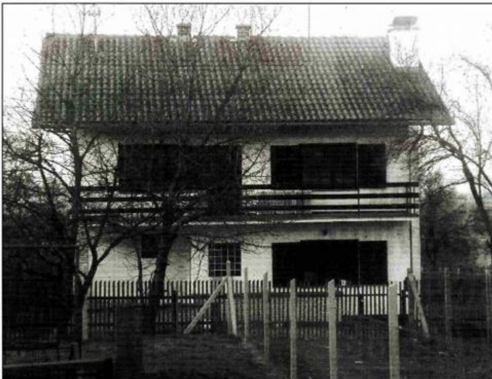
Kuća u Grobljanskoj 13 trenutačno je u fazi opremanja i dovršetka radova
